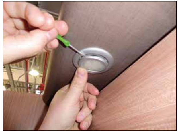
Abb. 47 Lampenwechsel am Einbauspot
